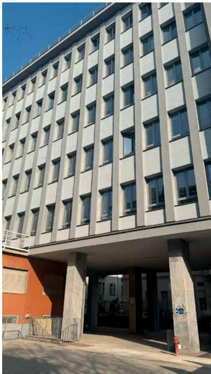
ta, l'installazione di nuovi serramenti esterni, realizzati in conformità con le normative vigenti, ha ulteriormente valorizzato l'edificio. Infine, la realizzazione di un cappotto termico sulle facciate esterne del corpo aule ha permesso di ottenere la certificazione energetica, concludendo in maniera positiva l'insieme degli interventi eseguiti.
